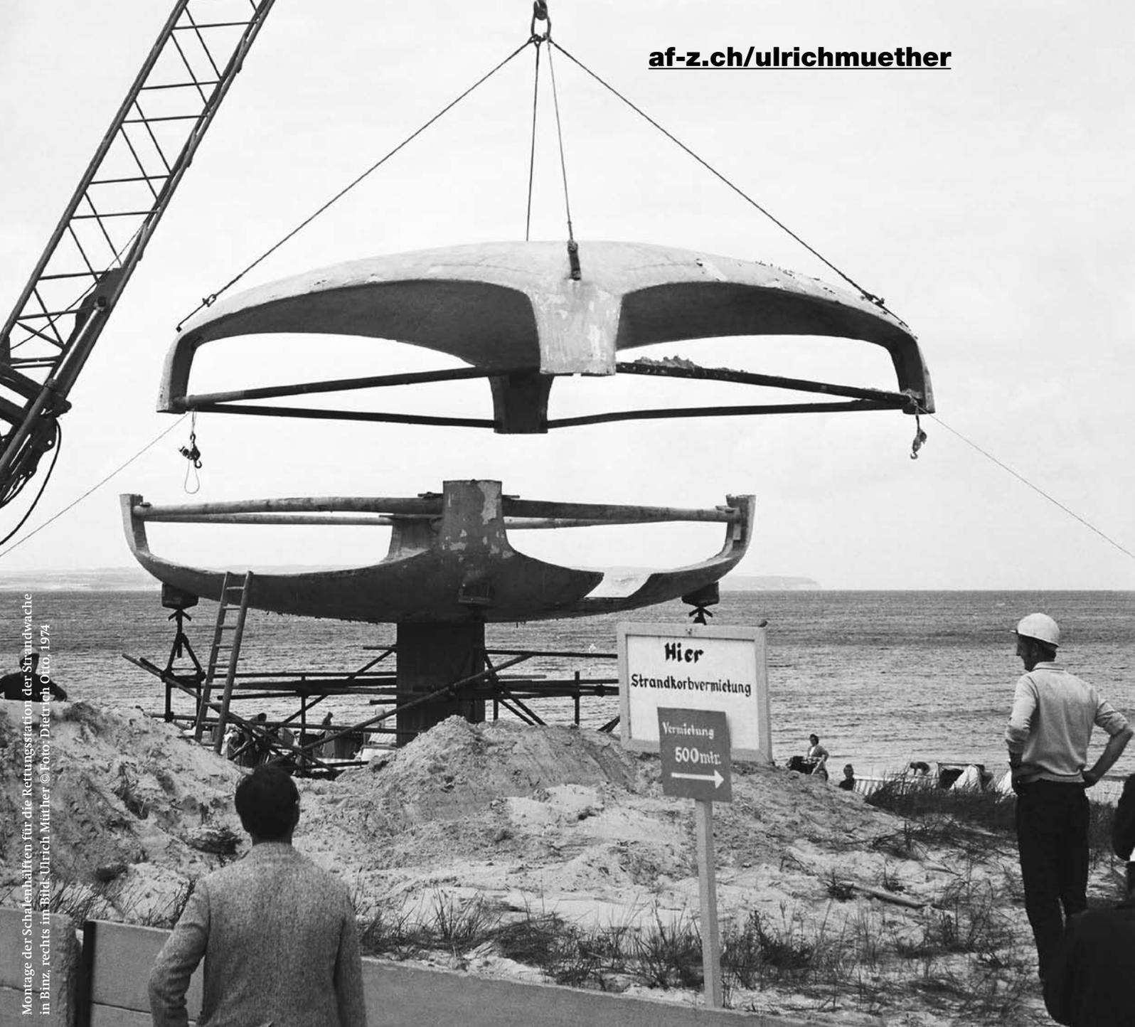
Montage der Schalenhälften für die Rettungsstation der Strandwache in Binz, rechts im Bild: Ulrich Müther © Foto: Dietrich Otto, 1974
