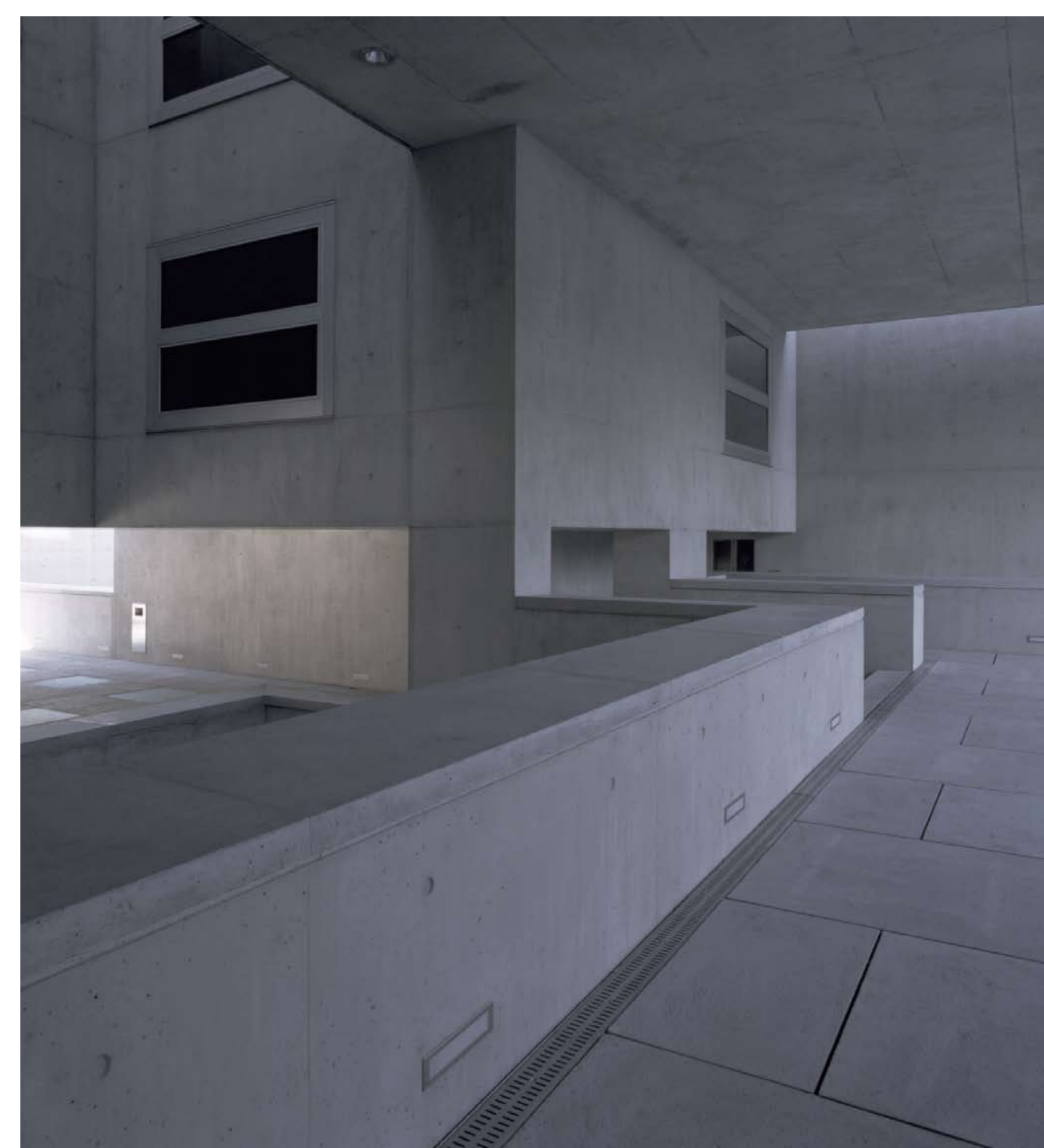
Terrasse und Hof Erdgeschoss
