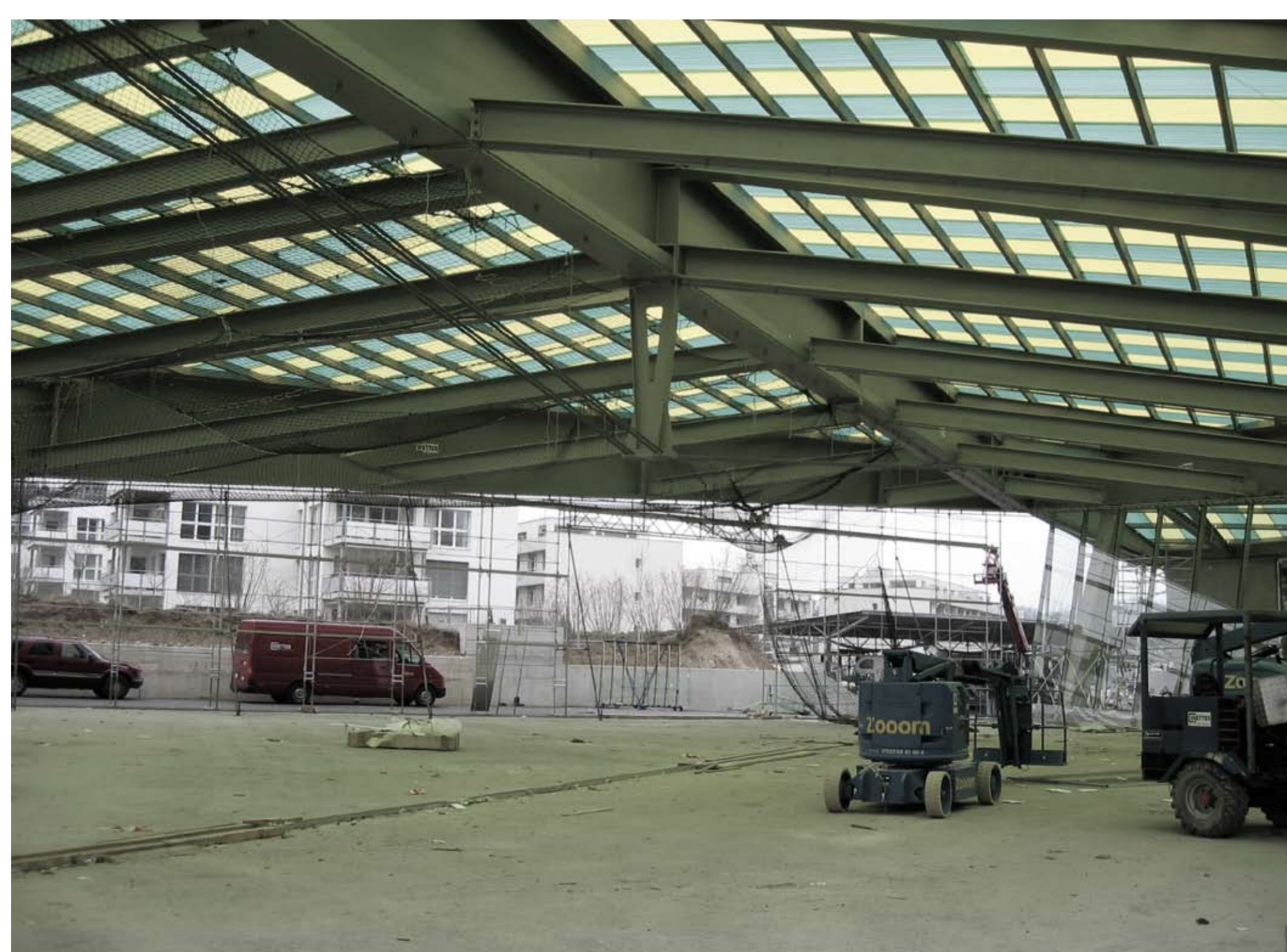
Unterspannter Diagonaltträger
