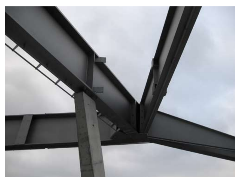
Knotendetails Haupttragstruktur
