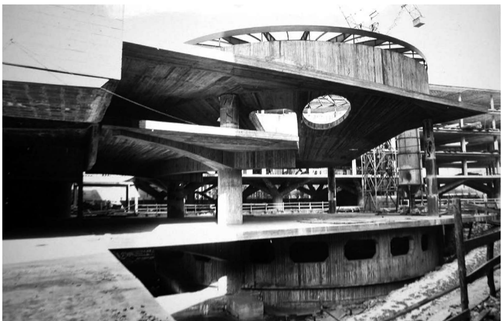
Rohbaufoto Sala Consiliare
