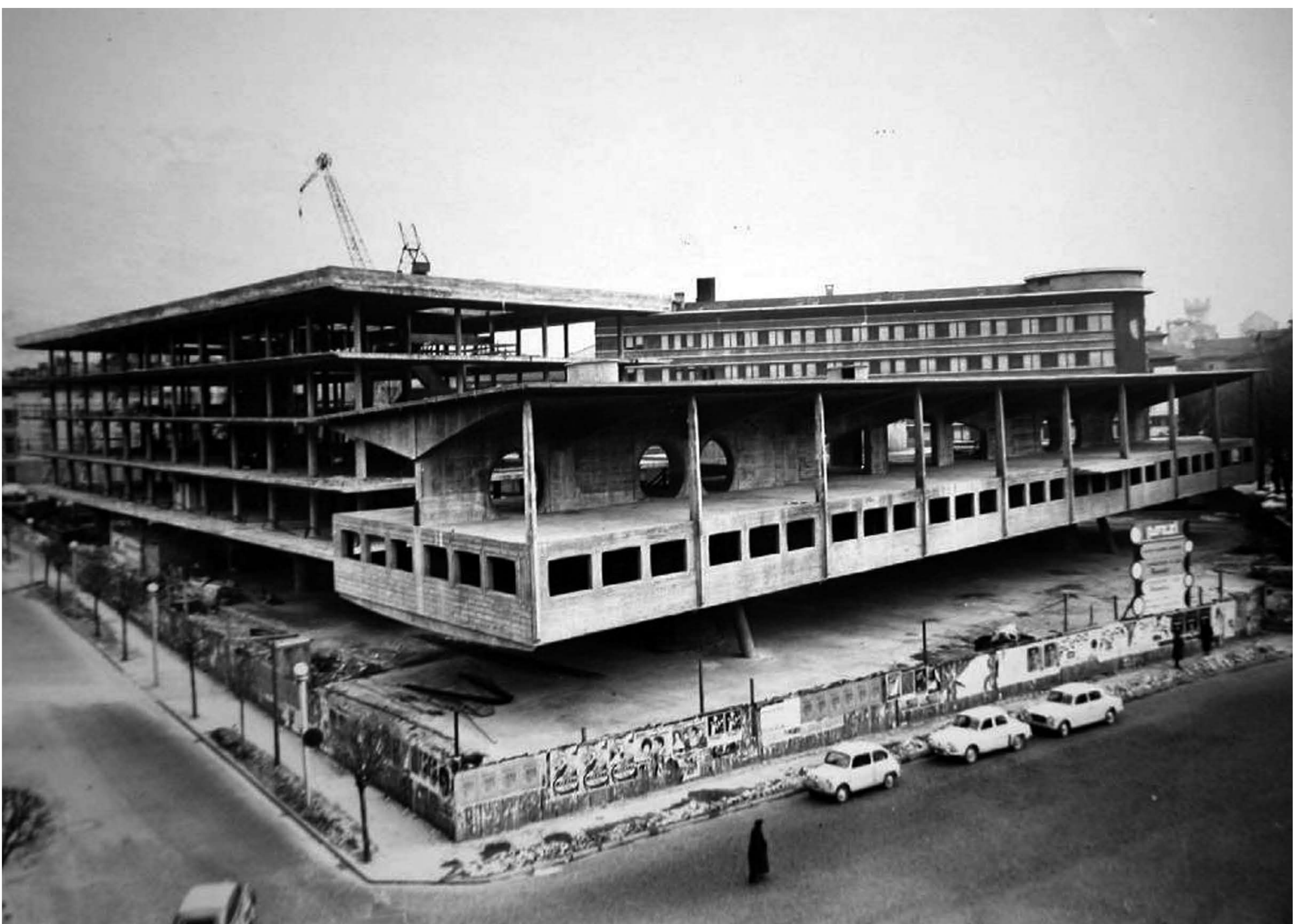
Baustellenfoto: im Vordergrund die Giunta, links das Edificio Assessorati
